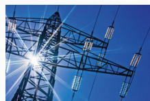
Haute & Basse Tension
